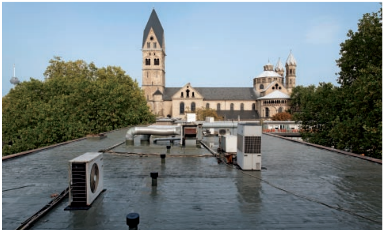
Die KEMPEROL®-Abdichtung wurde in der Fläche ohne Grundierung direkt auf dem entsprechend vorbereiteten Bitumenuntergrund verlegt.
