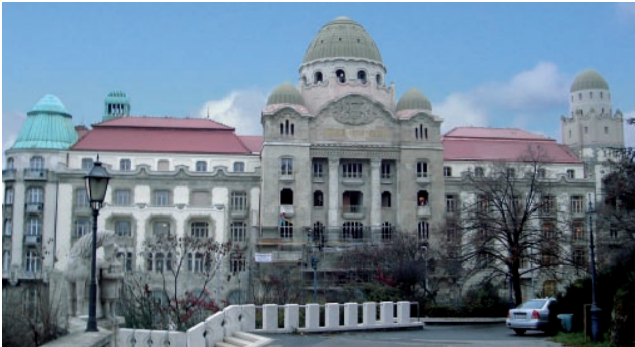
Das Hotel Gellért kurz vor Ende der Sanierung. Die Kuppeln wurden mit KEMPEROL® abgedichtet.
