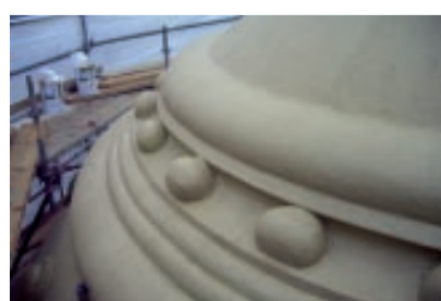
Diffizile Strukturen sind ideal für eine Flüssigabdichtung.
