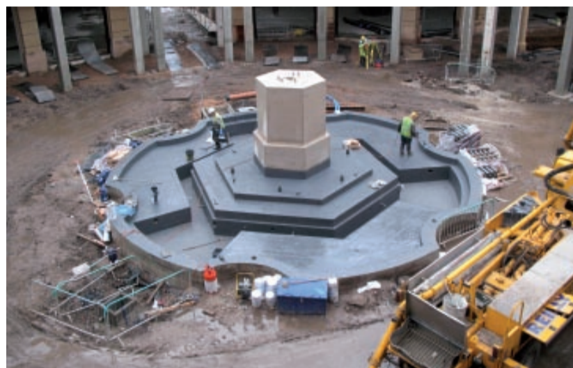
Die untere und die mittlere Schale des Wasserspiels wurden mit KEMPEROL® abgedichtet.
