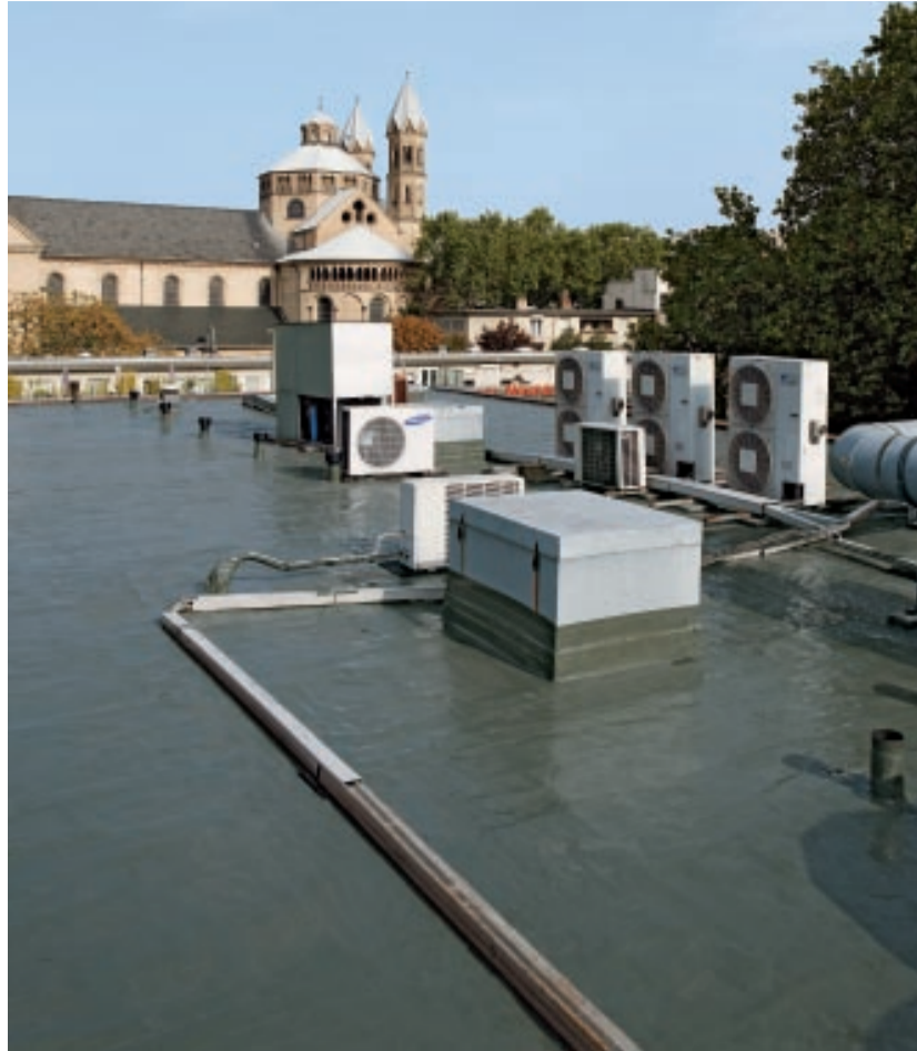
Der Trend zur Klimaanlage hat sich mittlerweile auch in Deutschland durchgesetzt. Bei der Abdichtung mit dem lösemittelfreien und geruchsneutralen KEMPEROL® 2K-PUR können sie einfach weiterlaufen.
