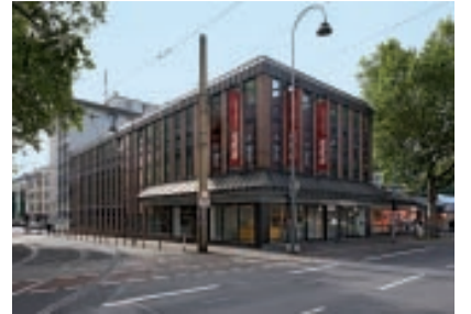
In der Kölner Innenstadt wurde das Flachdach eines Geschäftshauses mit KEMPEROL® 2K-PUR neu abgedichtet.
