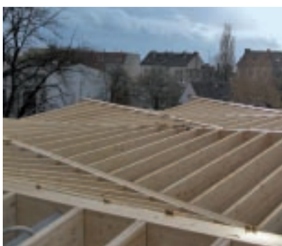
Das Dach ist in Form eines versetzten Faltenwerks konstruiert.
