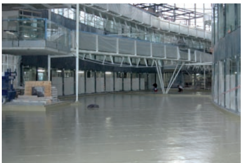
2.500 Quadratmeter Fläche wurden insgesamt mit dem geruchsneutralen KEMPEROL® 2K-PUR abgedichtet.
