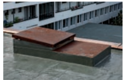
Die kleinformige Geometrie im Detail verlangte eine Flüssigabdichtung.
