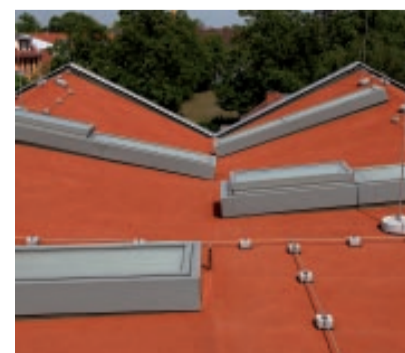
Anschlüsse werden mit KEMPEROL® sicher in die Flächenabdichtung eingebunden.
